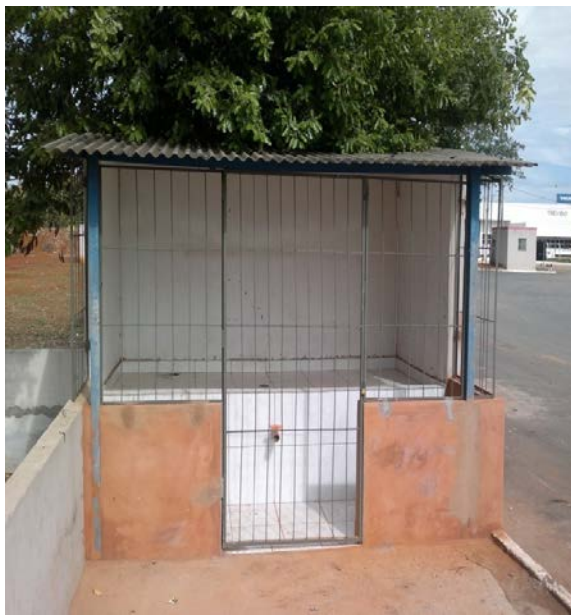
Figura 1: Armazenamento temporário dos resíduos perigosos gerados em um posto de combustível
