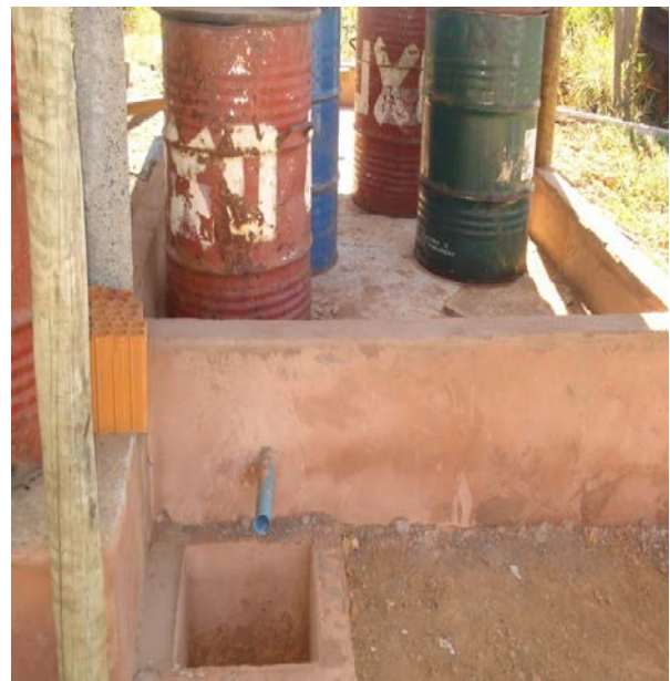
Figura 1: Armazenamento temporário dos resíduos perigosos gerados em um posto de combustível
